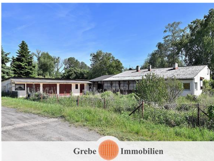
Blick von der Straße
